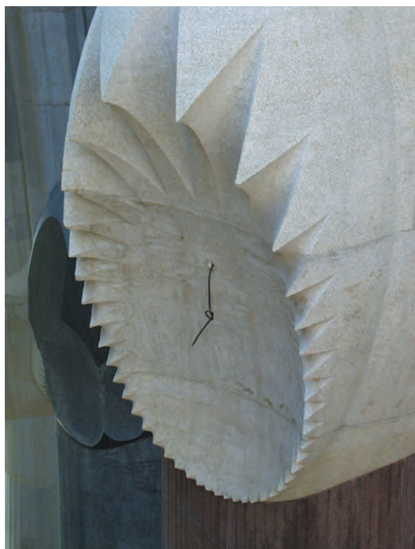
FIGURA 34. Detall del nus de les columnes de la nau central, amb estrellats generats per paraboloides.
