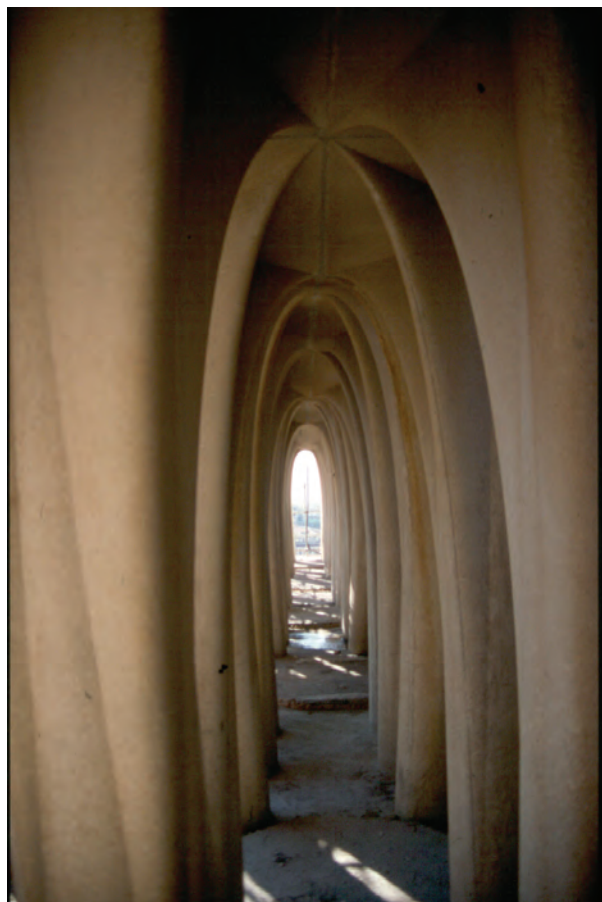
FIGURA 32. Passadís de columnes generades per paraboloides.
