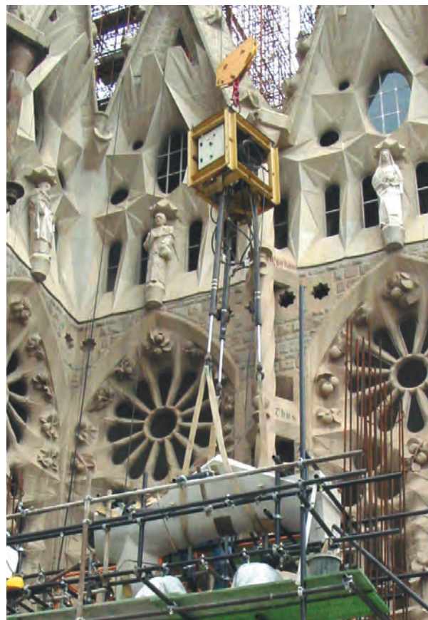
FIGURA 37. Trípod hidràulic per a la col·locació de peces.
