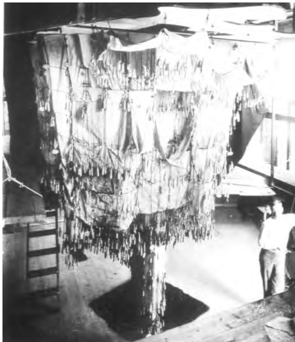
FIGURA 8. Maqueta polifuncional invertida de l'església de la Colònia Güell.
